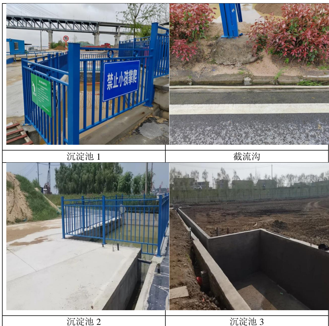
图 6.3-3 径流雨水防治措施图
